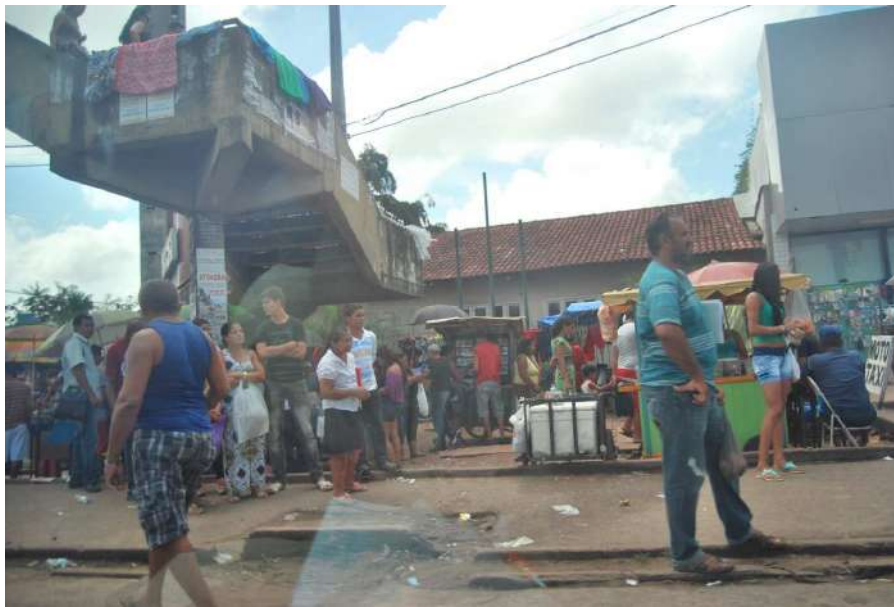
Figura 4.37 Acesso á Passarela Dificultado pela Falta de Infraestrutura, BR 316, Km 9, Sentido Crescente, Março/2013.
