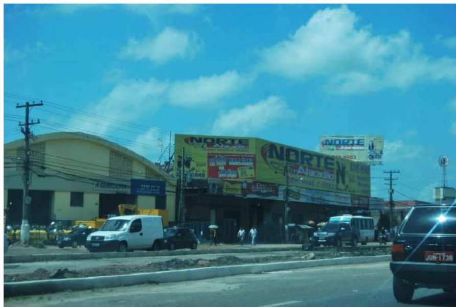
Figura 4.34 Canteiro Central Sem Urbanização, BR 316, Km 7, Sentido Decrescente, Março/2013.
