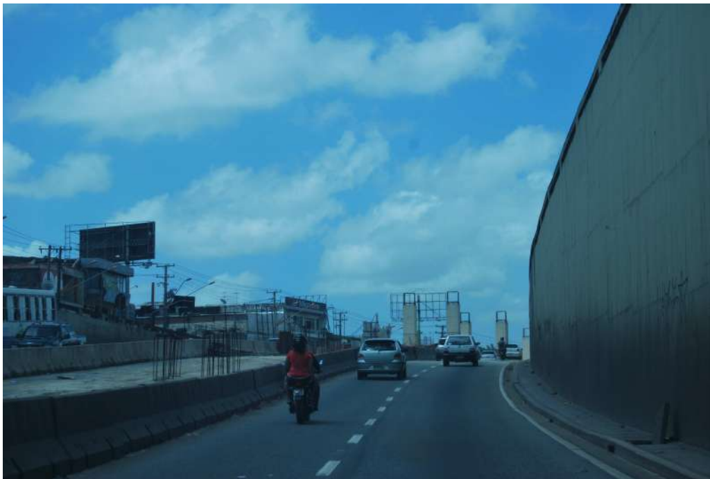
Figura 4.39 Obras Inacabadas Ocupam Faixa, BR 316, Km 0, Sentido Decrescente, Março/2013.
