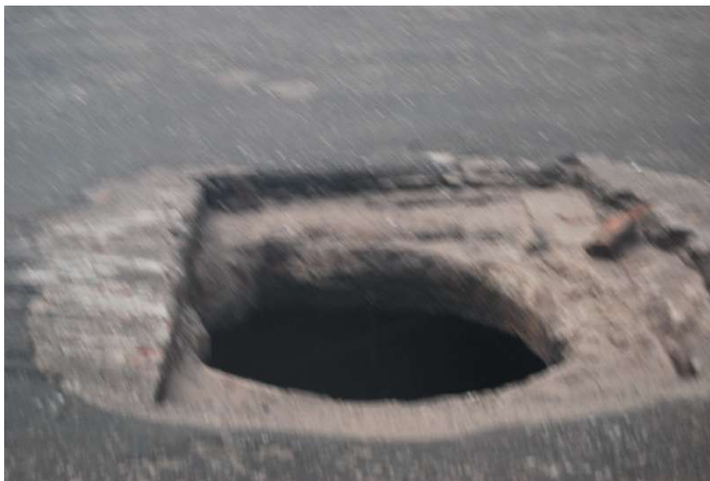
Figura 4.49 Grande Buraco na Via, BR 316, Km 5, Sentido Crescente, Março/2013.
