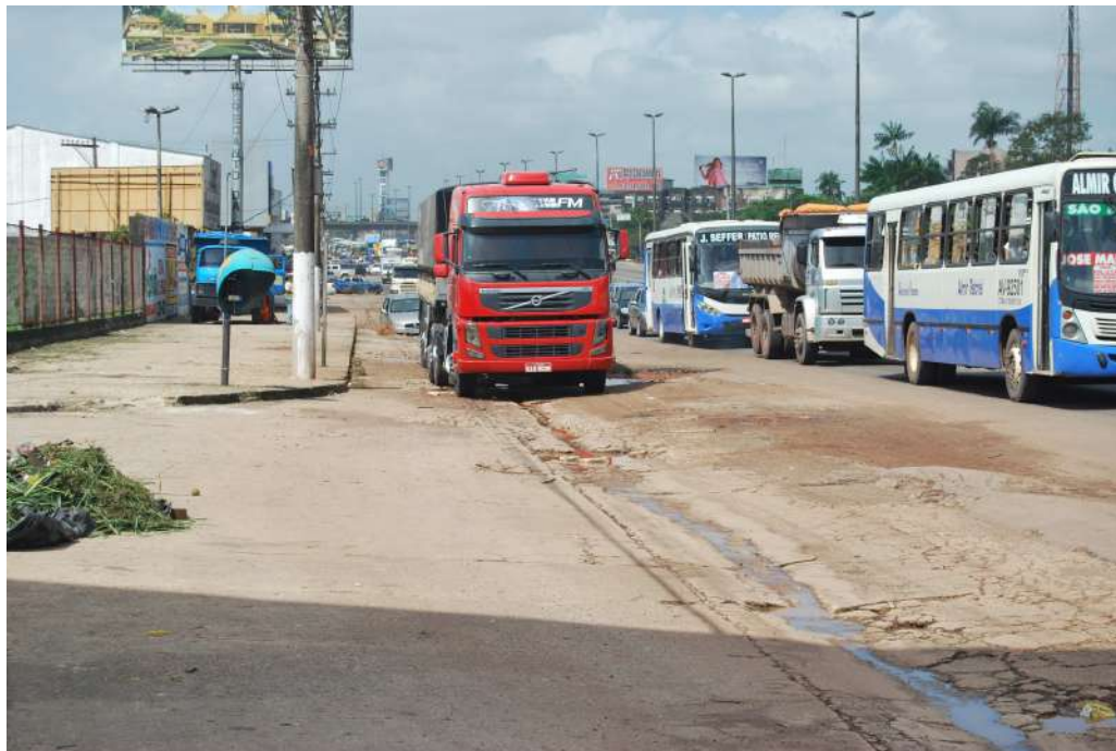
Figura 4.18 Falta de Qualidade da Pista, Presença de Buracos, BR 316, Km 6, Sentido Crescente, Março/2013.
