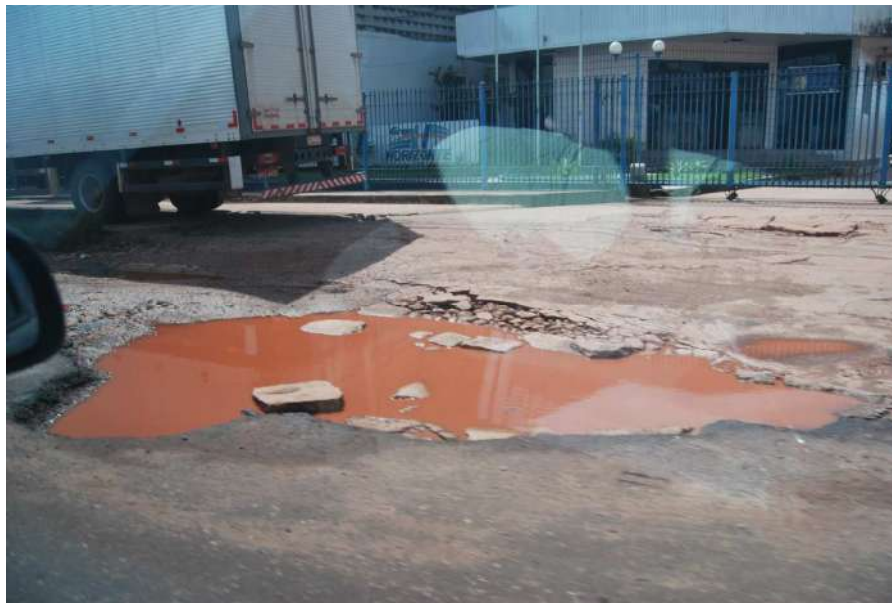
Figura 4.29 Buracos no Acostamento, BR 316, Km 7, Sentido Crescente, Março/2013.
