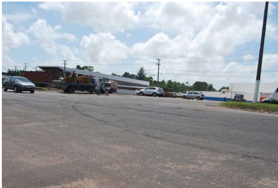
Figura 4.20 Imperfeição na Saída do Retorno, Ausência de Delimitação de Faixas e Acostamento, BR 316, Km 9, Sentido Decrescente, Março/2013.
