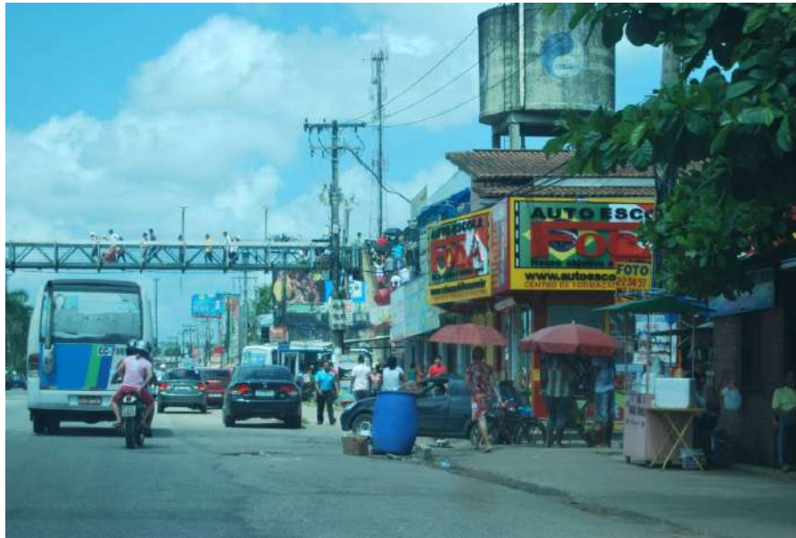
Figura 4.36 Falta de Sinalização Contrastando com a Passarela, BR 316, Km 9, Sentido Decrescente, Março/2013.
