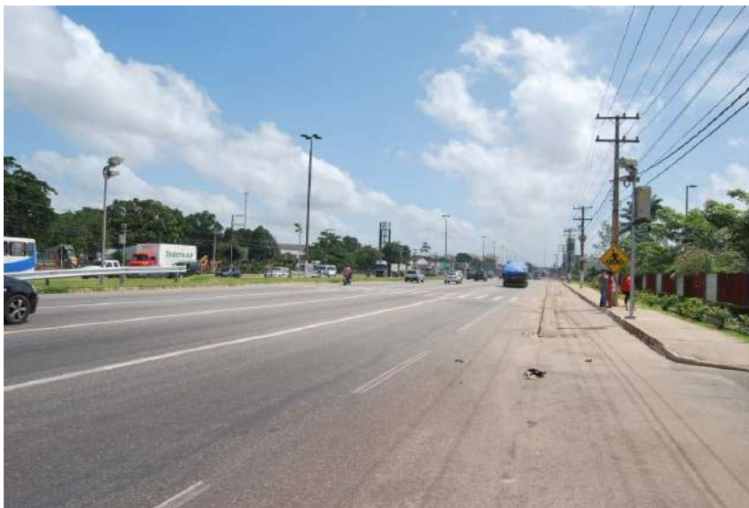
Figura 4.42 Faixa de Pedestre Apagada, Dificuldade de Visualização por Parte do Conductor, BR 316, Km 8, Sentido Crescente, Março/2013.
