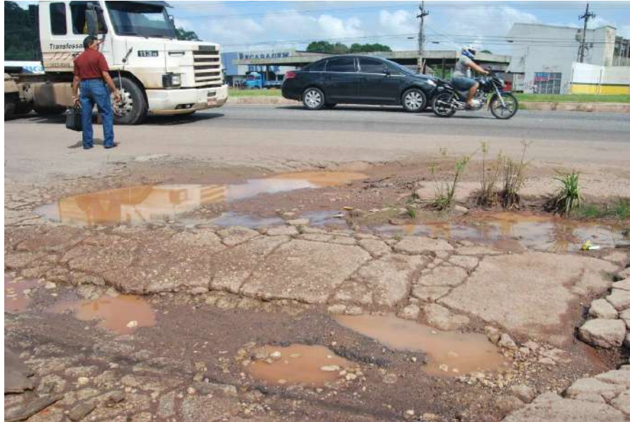
Figura 4.28 Buracos no Acostamento, BR 316, Km 6, Sentido Crescente, Março/2013.
