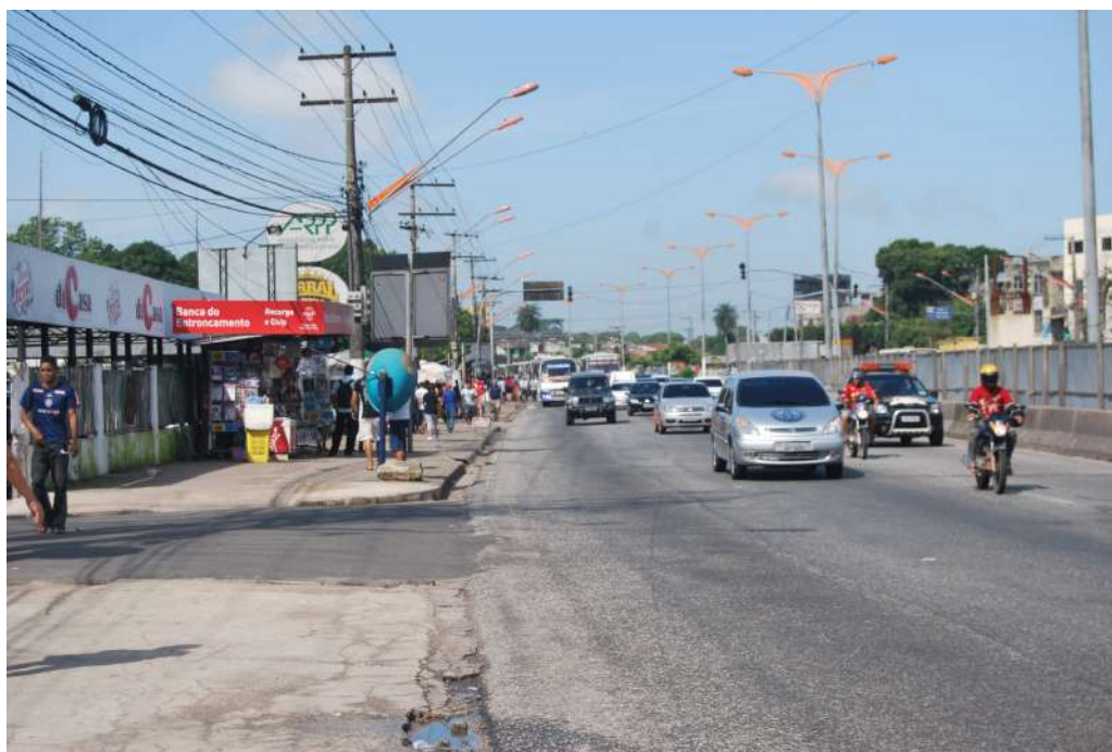
Figura 4.48 Falta de Sinalização Vertical, BR 316, Km 0, Sentido Crescente, Março/2013.
