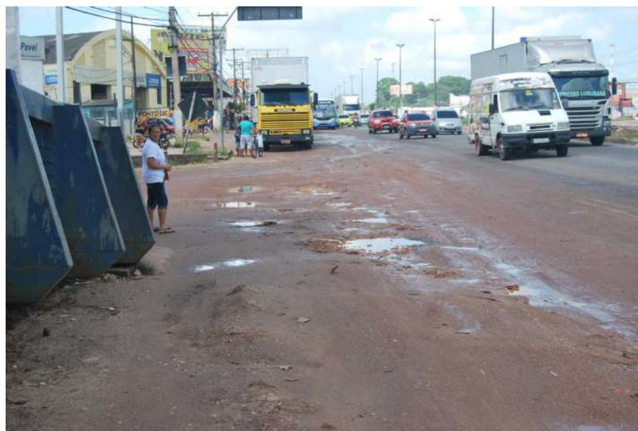
Figura 4.25 Acostamento Transformado em Parada de Ônibus, BR 316, Km 7, Sentido Crescente, Março/2013.
