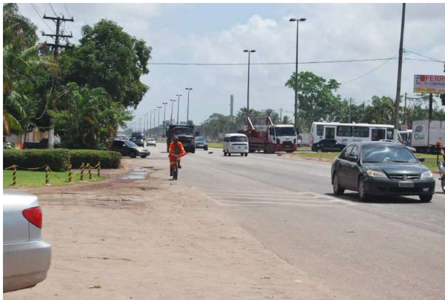
Figura 4.22 Retorno, BR 316, Km 7, Sentido Decrescente, Março/2013.
