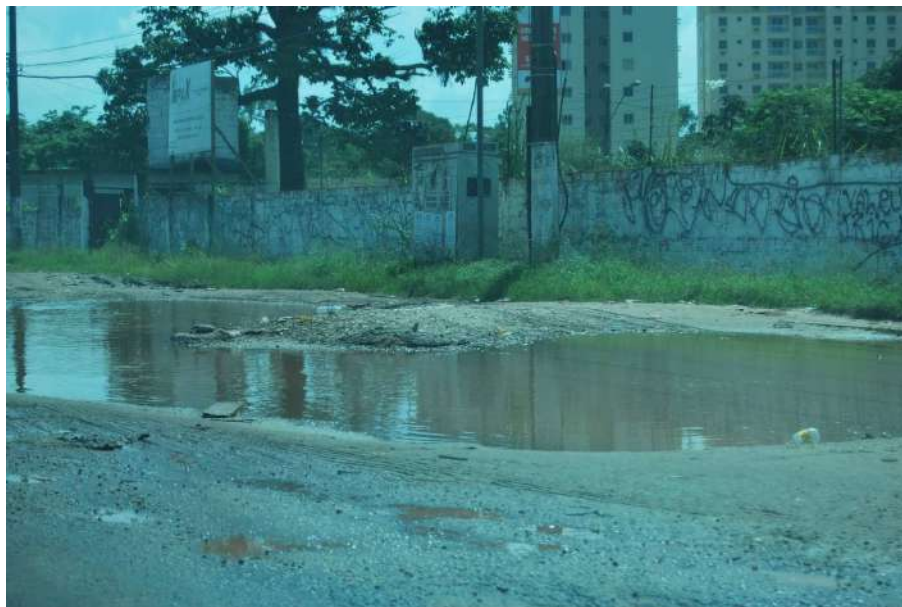
Figura 4.31 Grande Volume de Água e Lama Empoçados no Acostamento, BR 316, Km 7, Sentido Crescente, Março/2013.
