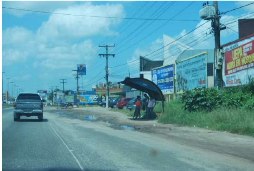
Figura 4.46 Parada de Ônibus Sem Calçada ou Recuo, BR 316, Km 7, Sentido Decrescente, Março/2013.
