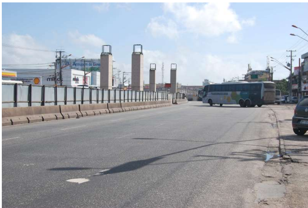
Figura 4.40 Obra Parada Dificulta o Tráfego, BR 316, Km 0, Sentido Crescente, Março/-2013.
