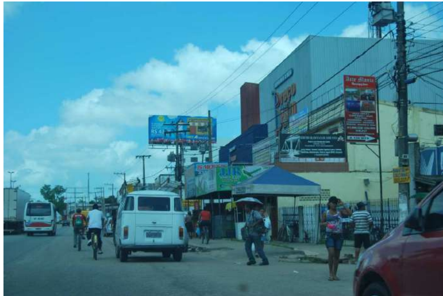
Figura 4.26 Ausência de Delimitação de Faixas e Acostamento, BR 316, Km 9, Sentido Decrescente, Março/2013.
