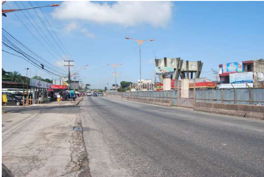
Figura 4.12 Restrição das Pistas de Rolamento Provocada por Obra Inacabada, BR 316, Aproximadamente Km 0, Sentido Crescente, Março/2013.
