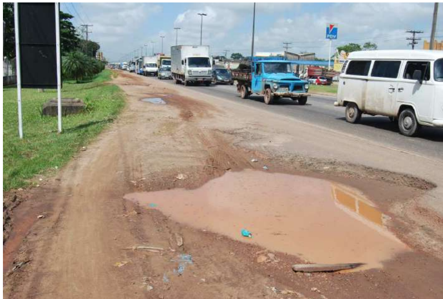
Figura 4.27 Precriedade do Acostamento, BR 316, Km 8, Sentido Crescente, Março/2013.
