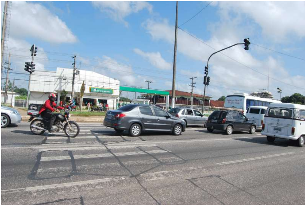
Figura 4.17 Trecho com Sinalização Semafórica, Retorno e Radar, Porém, Sem Faixas Adequadamente Pintadas, o Que Contribui para Engarrafamentos, BR 316, Km 3, Sentido Crescente, Março/2013.
