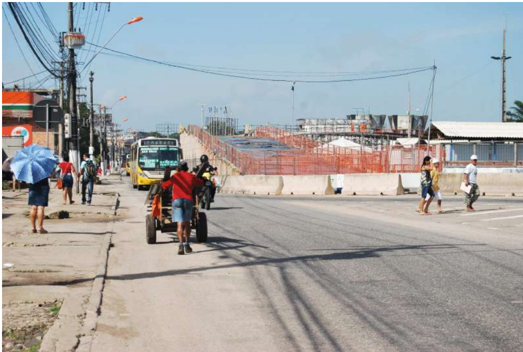
Figura 4.16 Restrição do Tráfego e Fluxo Intenso de Usuários, BR 316, Km 0, Sentido Crescente, Março/2013.
