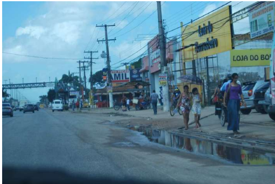
Figura 4.30 Falta de Drenagem Causando Acúmulo de Água no Acostamento, BR 316, Km 9, Sentido Decrescente, Março/2013.
