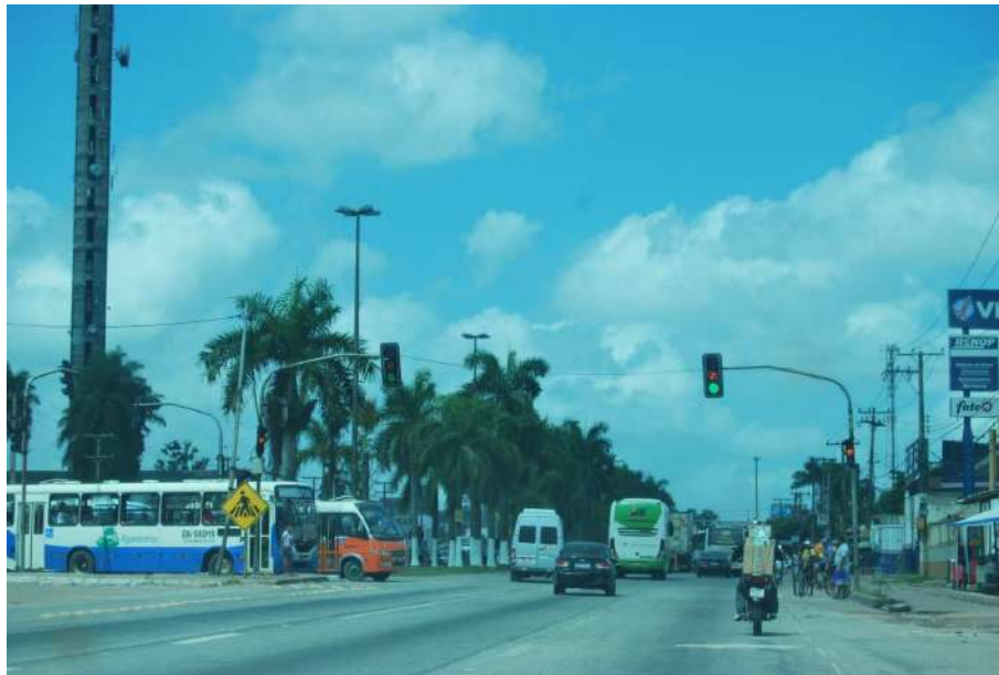
Figura 4.11 Destaque às Pistas de Rolamento, BR 316, Aproximadamente Km 9, Sentido Decrescente, Março/2013.
