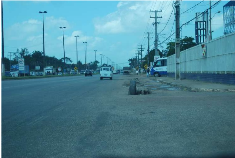
Figura 4.54 Buracos, Sujeira e Falta de Sinalização, BR 316, Km 8, Sentido Decrescente, Março/2013.
