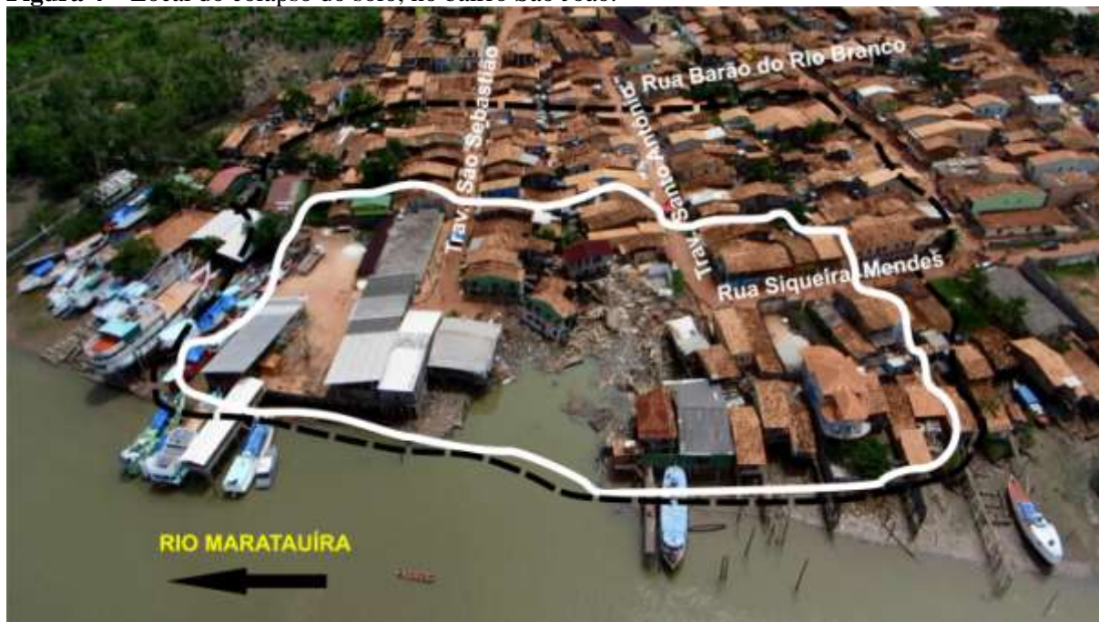
Figura 4 – Local do colapso do solo, no bairro São João.
